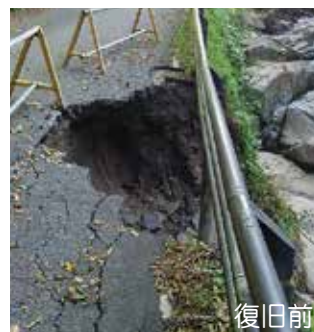
県道石沢字荻田線(二本松市太田地区内)
